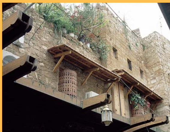
Les travaux ordinaires d'entretien sont toujours nécessaires
