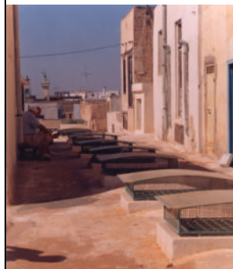
Ouvrages associés : percements formant puits de lumière
