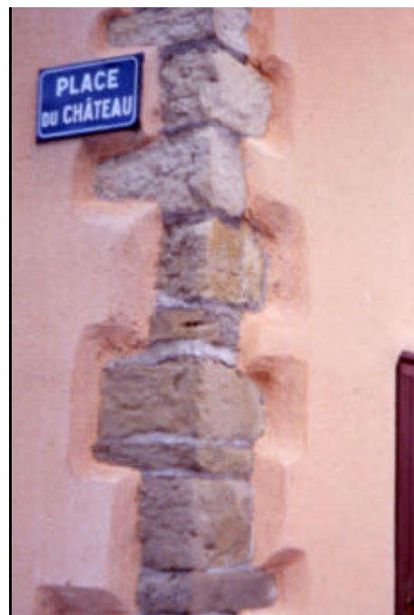
Evolution des techniques Matériaux = enduit prêt à l'emploi teinté en masse, finition gratté
