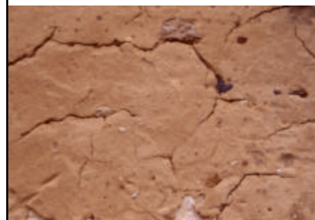
Pathologie liée à la technique Faïençage et usure accélérée
