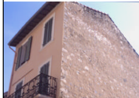
Usure et apparition des têtes de moellons
