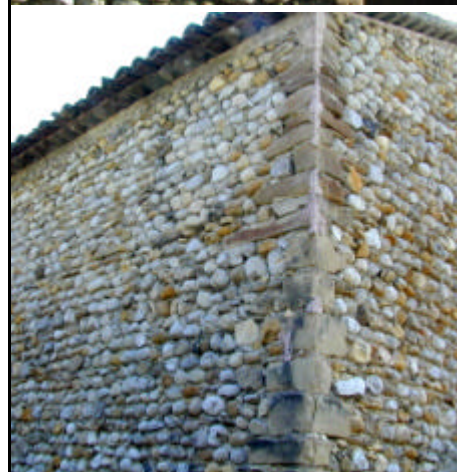
Ouvrages associés : Traitements d'angle
