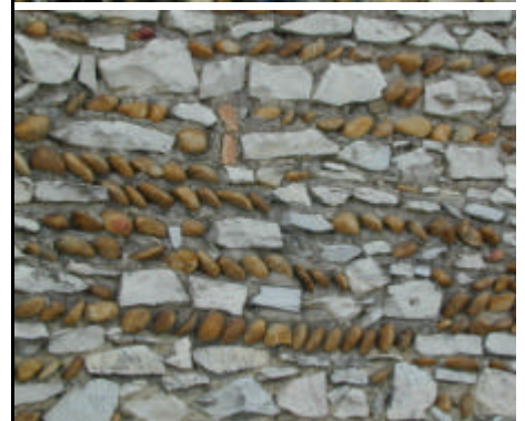
Mise en oeuvre : exemples variés
