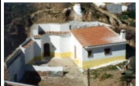
Nouveau volume annexe d'une habitation troglodytique réhabilitée
